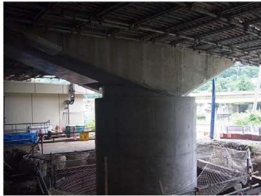
《施工後》 関越道 万太郎橋
